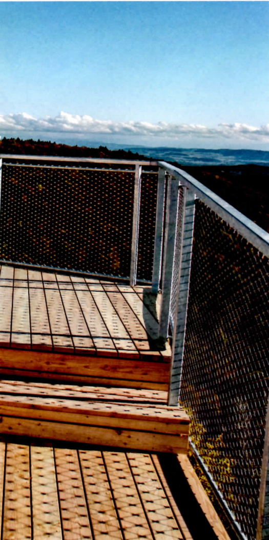
Die Lärchenholzplattformen sind mit einem Stahlgeländer gesichert.
