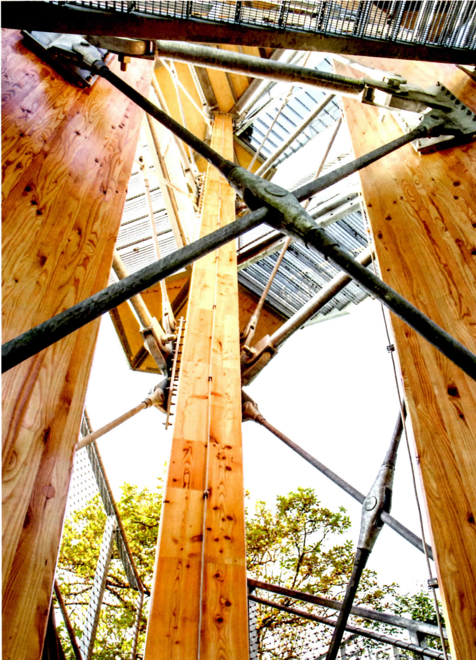
Die Konstruktion besteht aus 25 Kubikmetern heimischem Lärchenholz und acht Tonnen Stahl.
