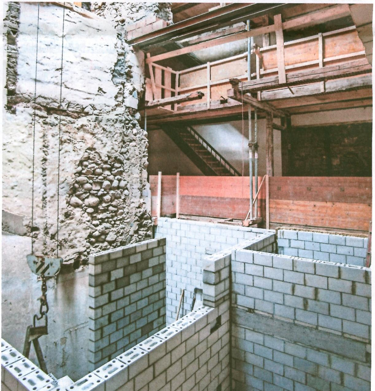
Kernstück der Totalsanierung: mit einer neuen, zentralen Steigzone werden die unterschiedlichen Geschossniveaus mit Treppe und Lift erschlossen.
