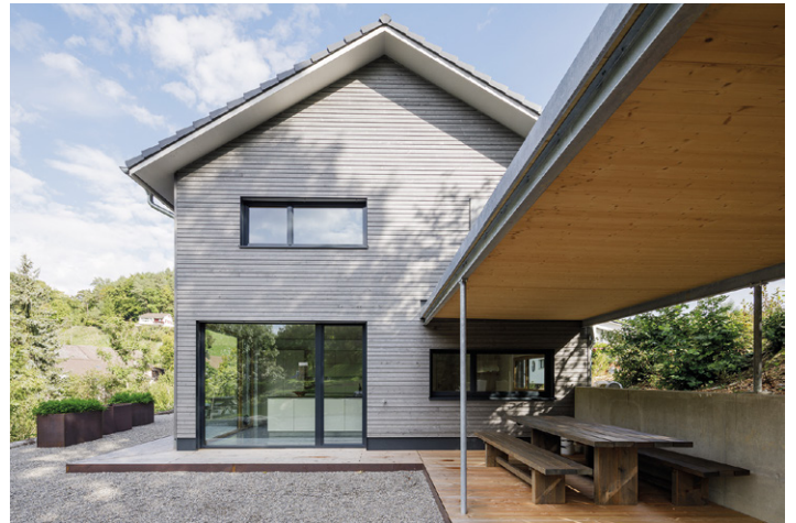
Ob als Konstruktionsmaterial, Fassade oder Gestaltungselement – Holz aus der Region steigert die lokale Wertschöpfung.
