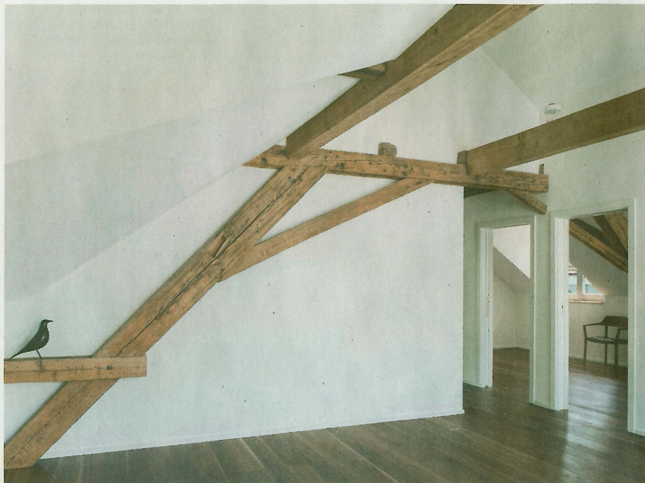
Auch der Ausbau des bisher unbewohnten Dachraumes kann, wie man sieht, sehr lohnenswert sein.
