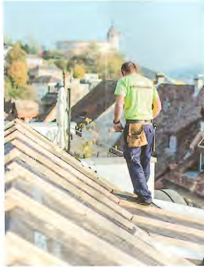
Eine Dachsanierung bringt viele Vorteile.
