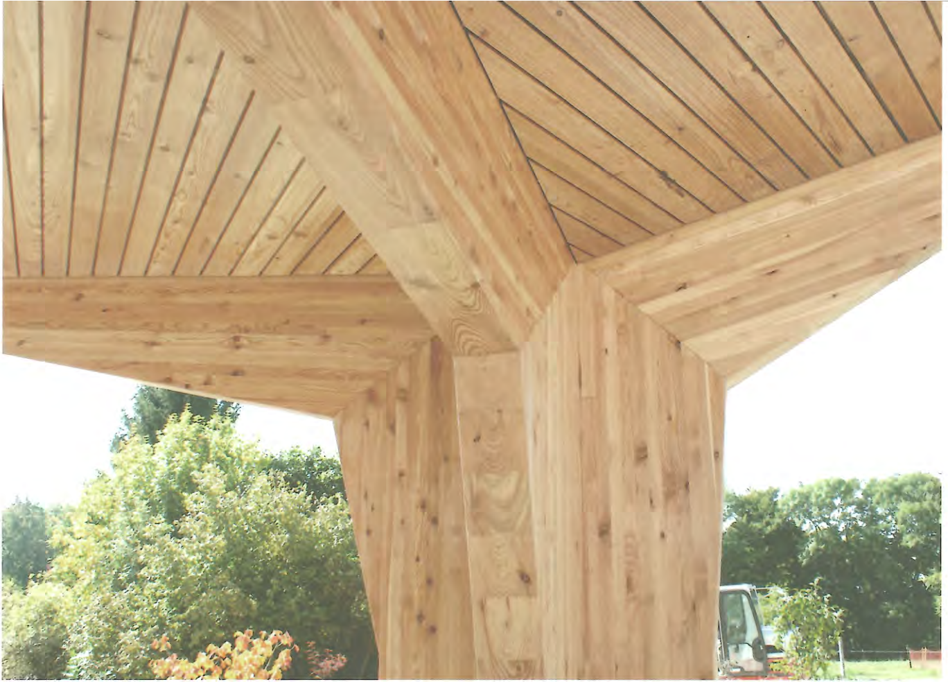
Das Dachtragwerk: Die beiden Stützen verzweigen sich zu je vier Kragarmen, die als Hauptträger dienen.
