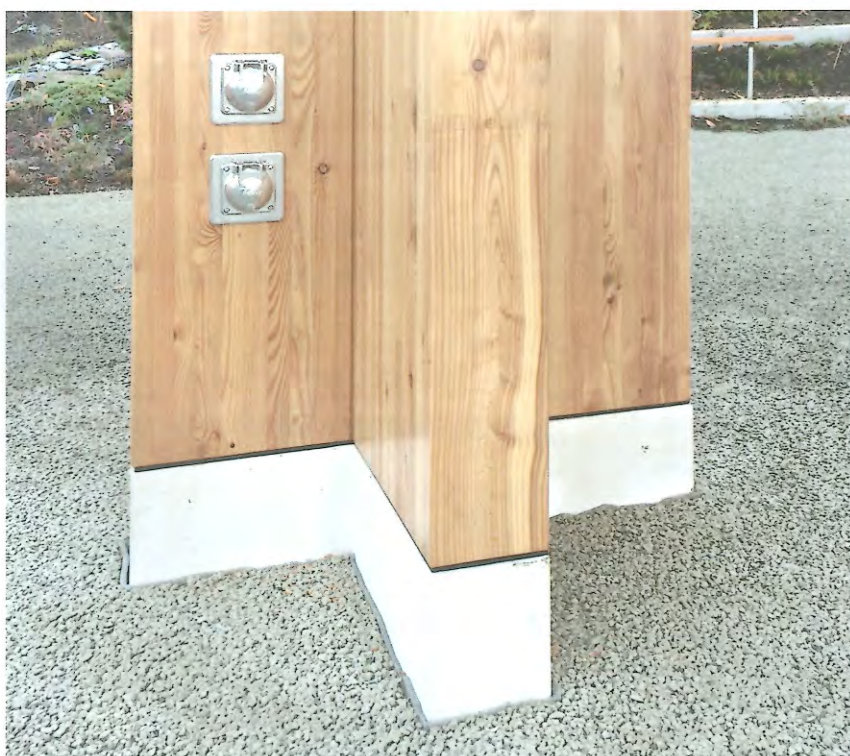
Eleganz durch Präzision: Der Anschluss der Stützen zum Betonfundament ist mit grosser Exaktheit ausgeführt.
